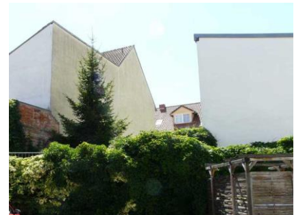
Abbildung 6: Baulücke aus Sicht Hof Nachbargrundstück
