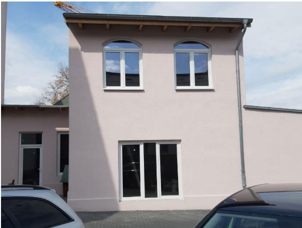
Abbildung 1: Eingang Hofseite, Fenster Wohnzimmer (EG) und Schlafzimmer (1.OG), Bauphase
